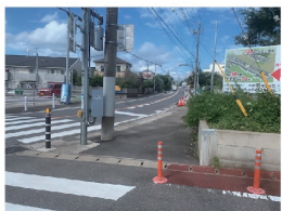
完了済み 土気小入口交差点歩行者だまり改良工事
