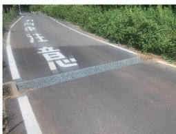
完了済み 辺田町横断側溝設置工事
