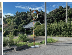
完了済み 中西町ミラー交換工事
