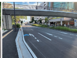
完了済み 鎌取駅南口左折レーン設置工事
